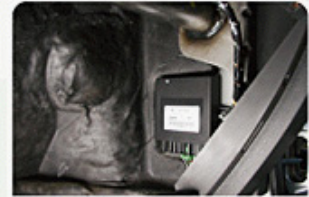
Localização do módulo do sistema de travamento das portas (RKE): fixado na lateral direita, atrás do porta-luvas.
