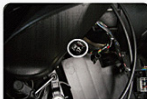
Motor do ventilador.
