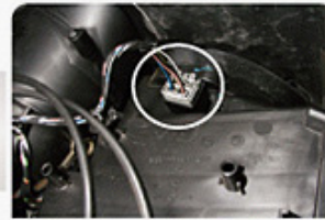
Resistências limitadoras de velocidade.
